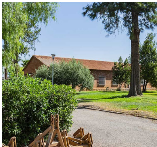
NOU INSTITUT D'INVESTIGACIONS AGRÀRIES (TRANSFORMACIÓ CENTRE CAPACITACIÓ)
