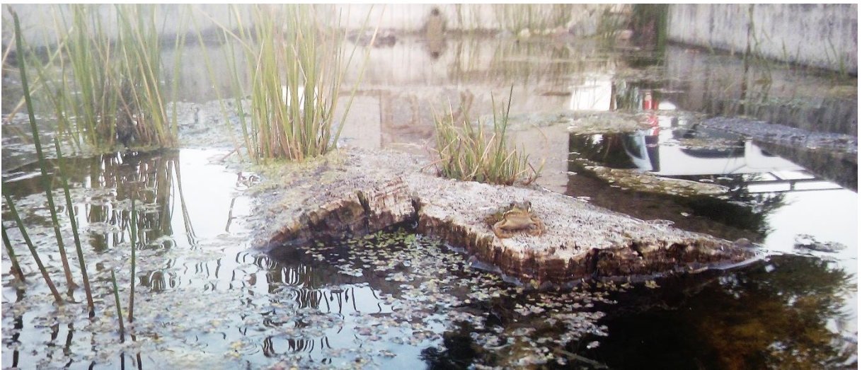
Rana común descansa sobre pequeña isla flotante vegetada con junco de agua, dispuesta en infraestructura de almacenamiento de agua de paredes verticales de hormigón.
